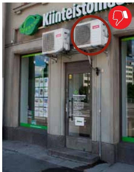
Kuva 59. Jälkiasennetut laitteet hallitsevat näkymää.
