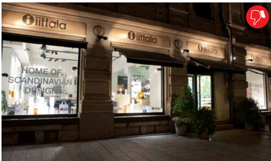
Kuva 71. Sisäänkäyntiä ei ole valaistu.
