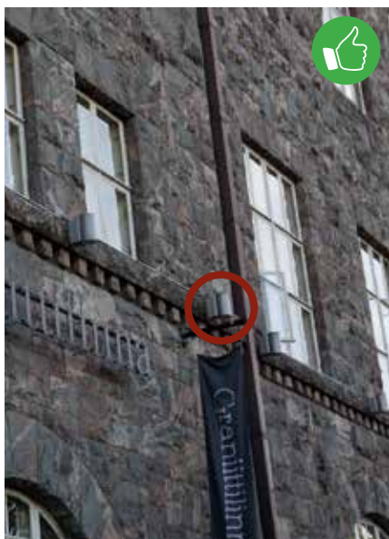
Kuva 53. Julkisivuun hyvin istuvat valaisimet.
