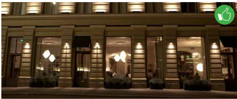
Kuva 68. Julkisivun valaistus on toteutettu pienitehoisilla kohdevalaisimilla, jotka luovat tunnelmaa.
