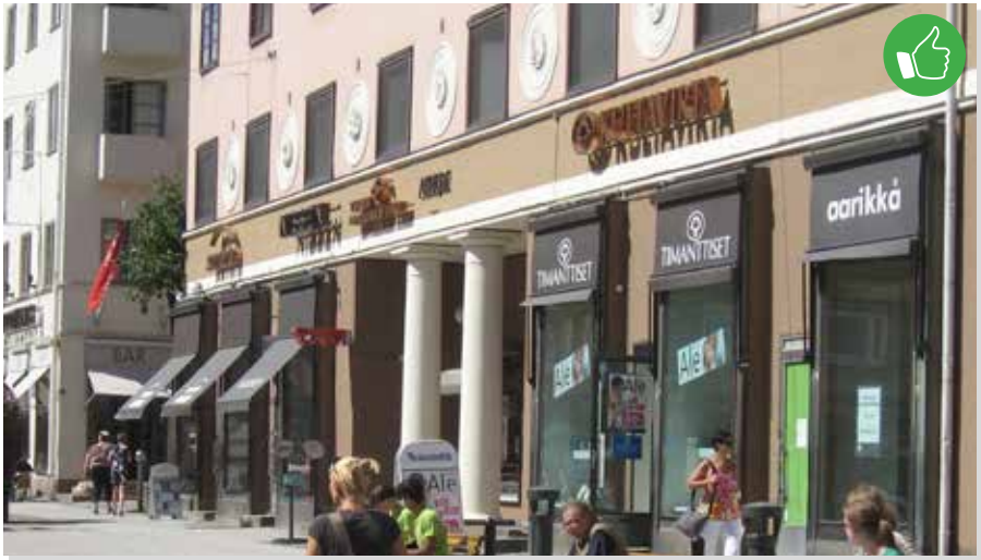
Kuva 112. Valomainosten yhtenäinen väri on lähellä seinän väriä. Rakennuksen historiallinen ilme ei häiriinny.
