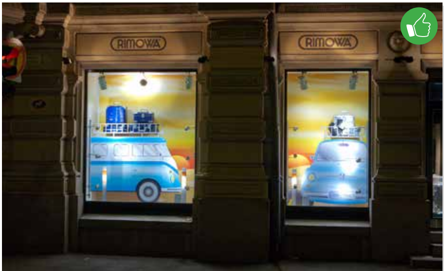
Kuva 65. Häikäisemätön lopputulos saadaan aikaiseksi oikealla asennustavalla. Kaikki valaisimet on suunnattu ikkunasta poispäin.
