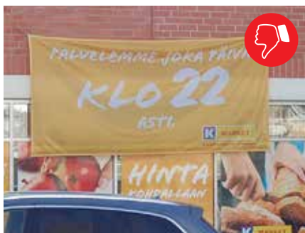
Kuva 92. Kangaskyltti on asennettu osin ikkunoiden ja tiiliseinän päälle. Materiaali ei ole paras vaihtoehto kyseiseen ympäristöön ja olosuhteisiin.
