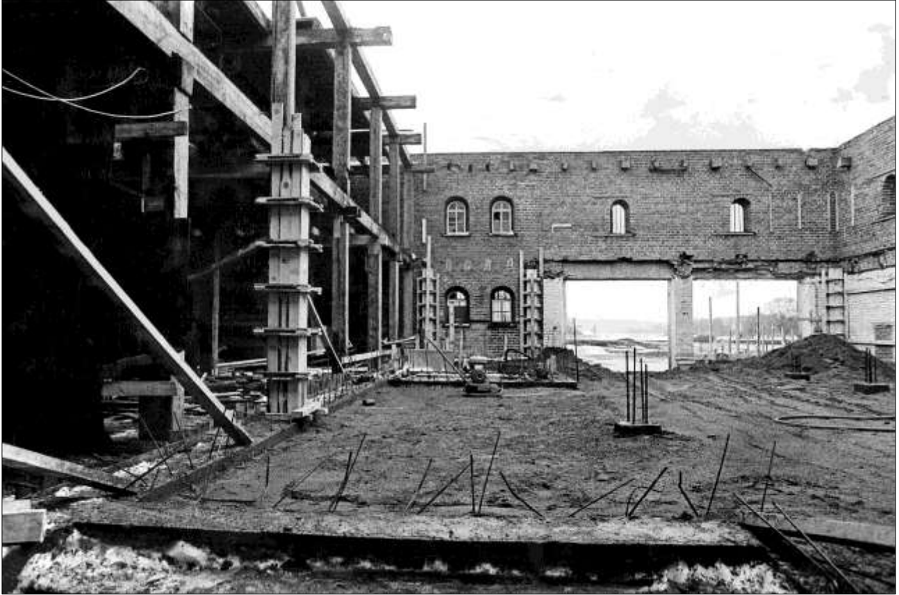
Makasiinin pohjoispää muutostyön kourissa 23.10.1982. Kuva on otettu nykyisen museon sisäänkäynnin kohdalta kohti takasivua. Vasemmalla näkyy laarien pilarirakenne ja vaakajuoksut. Takaseinällä 1. ja 2. kerroksen ikkunoiden välissä näkyy aikaisempien betoniportaiden tieltä katkaistut ja umpeen muuratut vaakajuoksujen kolot. 3. kerroksen juoksut on katkaistu ilm. tässä remontissa. Takasivun vasen autotallin oviaukko jätettiin käyttöön, mutta oikeanpuolimmainen muurattiin umpeen. Takaseinästä voi päätellä, että tähän osaan aikaisemmin tehty, 1. ja 2. kerroksen välinen betoniholvi ei ulottunut porraskäytävän kohdalle. SLNMM 99:4.
