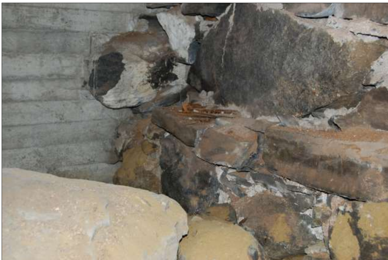
Makasiinin rossipohjan eteläpään julkisivun puoleinen perusta 24.10.2012. Alaosa on ladottu leveämmäksi anturaksi. MMT, 21_SLN_Riihisaari_24102012.jpg.
