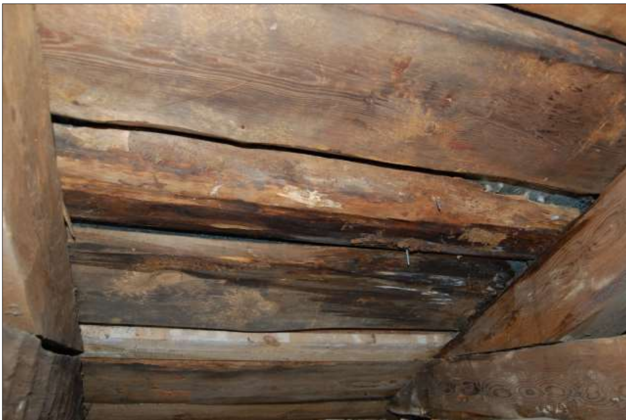
Makasiinin kolmas kerros, takasivu, keskikohdan ja pohjoispään puoliväli. Ruodelaudoitus (tuppilauta) on vuosien 1851–1852 aikaista. MMT, 30_SLN_Riihisaari_24102012.jpg
