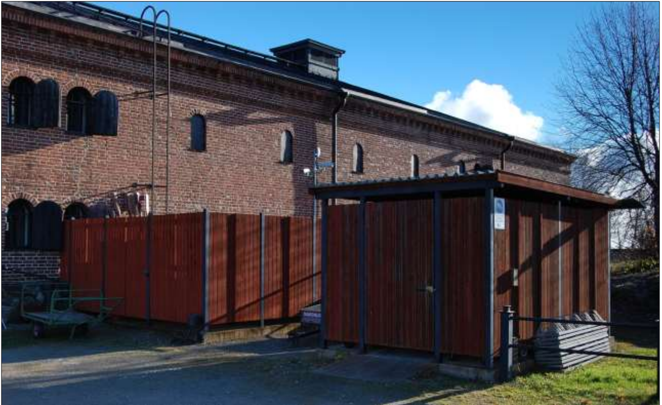
Makasiinin takasivun liuosjäähdytinaitaus ja jätekatos vuodelta 2003. Oikealla näkyy saman vuonna valmistunutta teräsaitaa. Kuvattu 25.10.2012. 28_SLN_Riihisaari_25102012.JPG.
