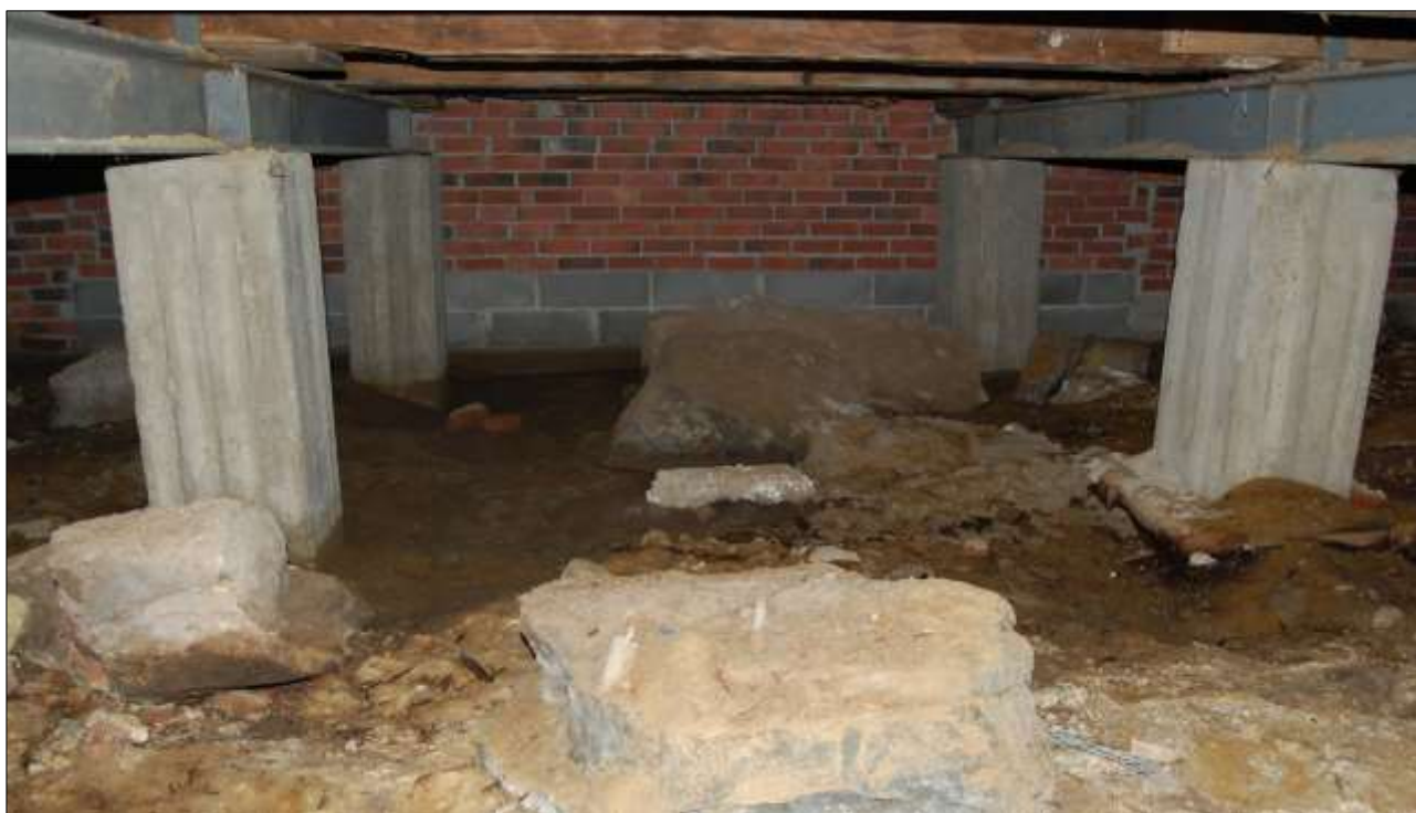
Makasiinin rossipohjan pohjoispäätä 24.10.2012. Betoni-tiili-Leca-harkkoseinän toisella puolella on rossipohjan keskimäinen osa, jonka lattialuukku on näyttelyrakenteiden alla piilossa. Etualan kivet ovat lattiavasojen kannattimia vuosilta 1851–1852. Ne korvattiin vuosien 1981–1984 aikana betonipilareilla ja teräspalkeilla. MMT, 05_SLN_Riihisaari_24102012.jpg.
