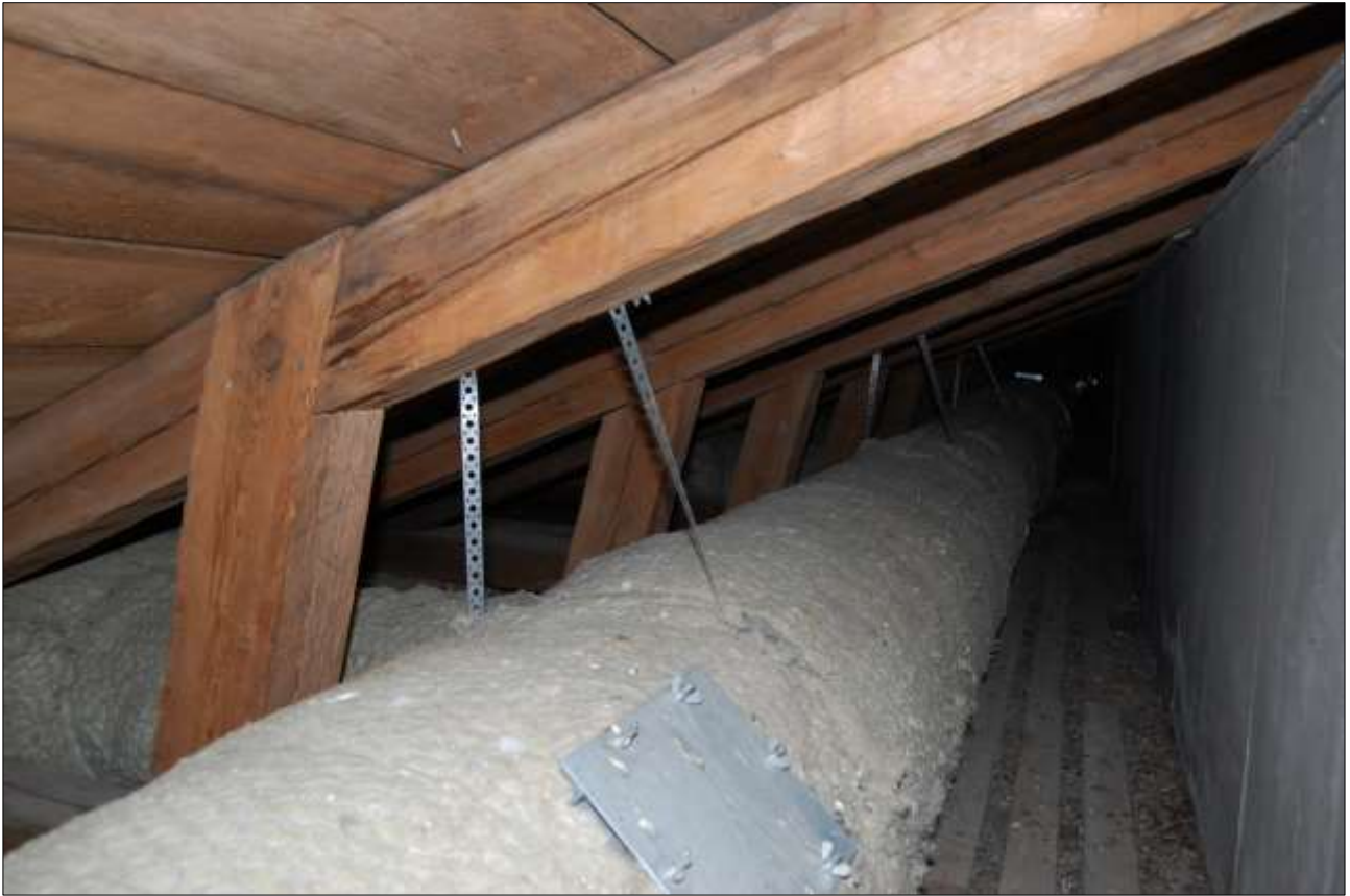
Makasiinin kolmas kerros, takasivu, keskikohta. Kattovasat, kontti- ja k p l rakenteet. Ruodelaudoitus on 1980-luvun alun kunnostuksen aikaista. MMT, 25_SLN_Riihisaari_24102012.jpg.
