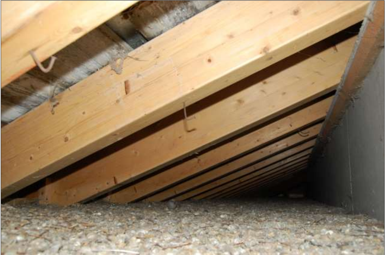
Makasiinin kolmas kerros, takasivu, pohjoisp  . Kattovasat (liimapuupalkit, Vierum  en Teollisuus Oy) ovat 1980-luvun alun kunnostuksen aikaista. MMT, 29_SLN_Riihisaari_24102012.jpg.
