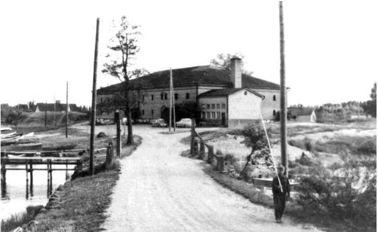
Riihisaari, 1950-luku. Kattolyhdyt on poistettu kokonaan ja tilalle laitettu pelti erottuu maalaamattomana. Makasiinin kummallakin sivulla erottuvat asuinparakit. SLNMM 78:16.
