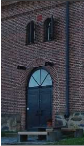
Makasiinin pääsisäänkäynti (ovessa on rakentamisaajan lukko). Kivijalka koostuu laastilla sidotuista kallionlohkareista. Ovi- ja ikkuna-aukoissa on puolikaaren muotoinen holvi. Ikkuna-aukkojen yläpuolella näkyy venäjänkielistä kirjoitusta sisältävät tiilet. MMT, 05_SLN_Riihisaari_25102012.jpg, osakuva.
