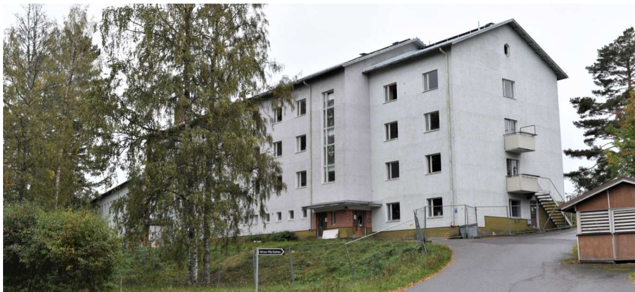
Kuva: Savonlinnan Pihlajakoti eli entinen vanhainkoti jäi tyhjilleen 2010-luvun alussa. Rakennukselle on myönnetty purkamislupa ja sen tilalle on suunniteltu vanhusten palvelutaloa.
