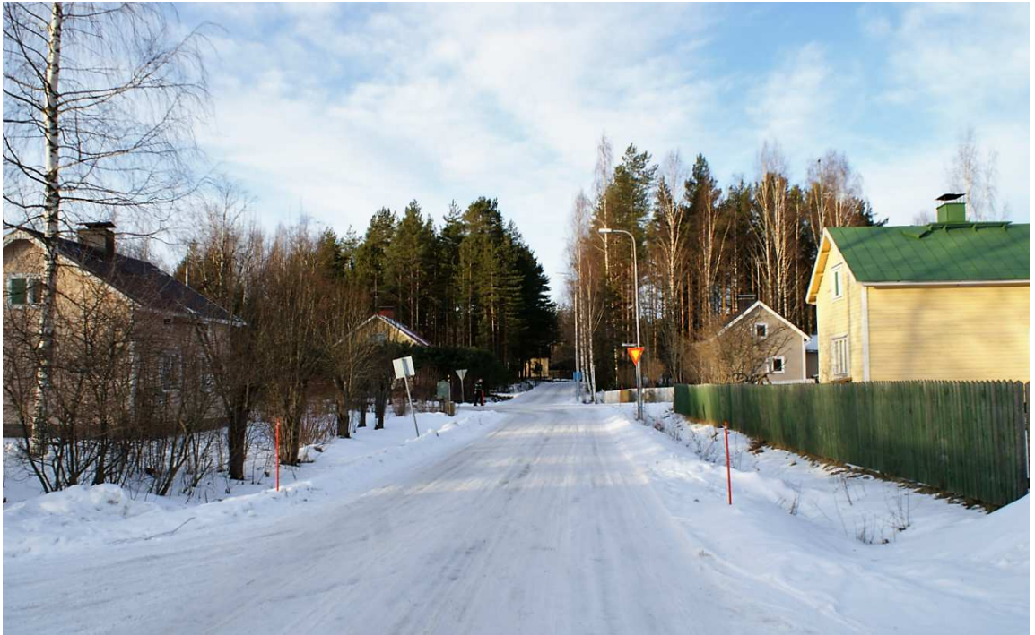
Kuva: Aseveltien ja Tuirontien risteys. Taloissa on harjakatot, joissa nykyään peltikate. Julkisivut ovat vaakalautoitettuja ja sokkelit maalattua betonia.
