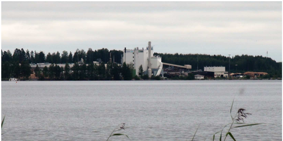
Kuva: Vaneritehdas kuvattuna Nobelinniemen venesatamaan johtavalta väylältä.
