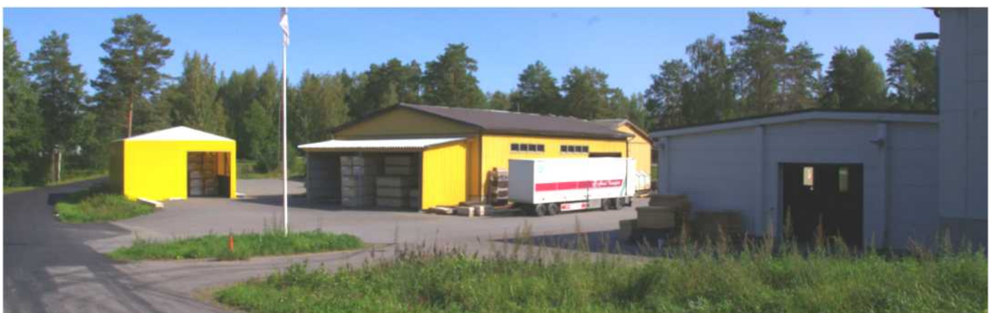
Puutaidon rakennuksia kuvattuna Taitotieltä.
