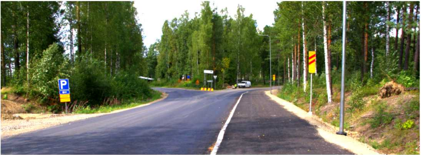
Tehtaankatua. Katu kääntyy vasemmalle MetsäWoodin tehtaalle, oikealle haarautuu katu Nobelinniemeen.
