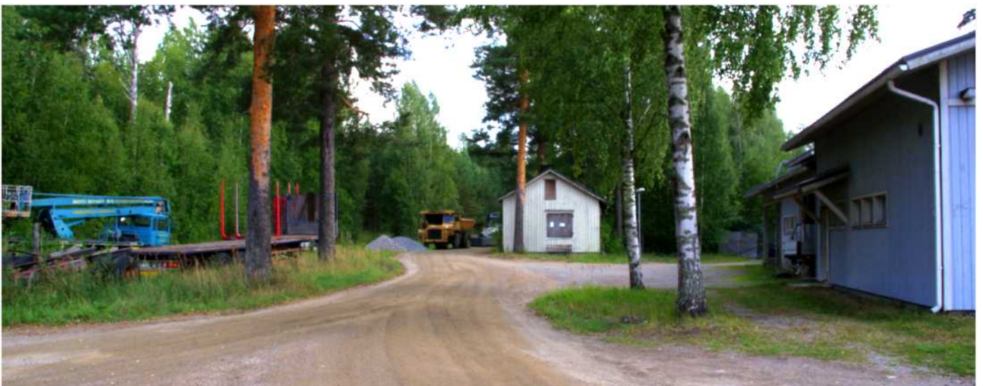
Nobelinniemeä kuvattuna luoteesta, Oikealla olevassa rakennuksessa pelastuslaitoksen ja vesilaitoksen tiloja.
