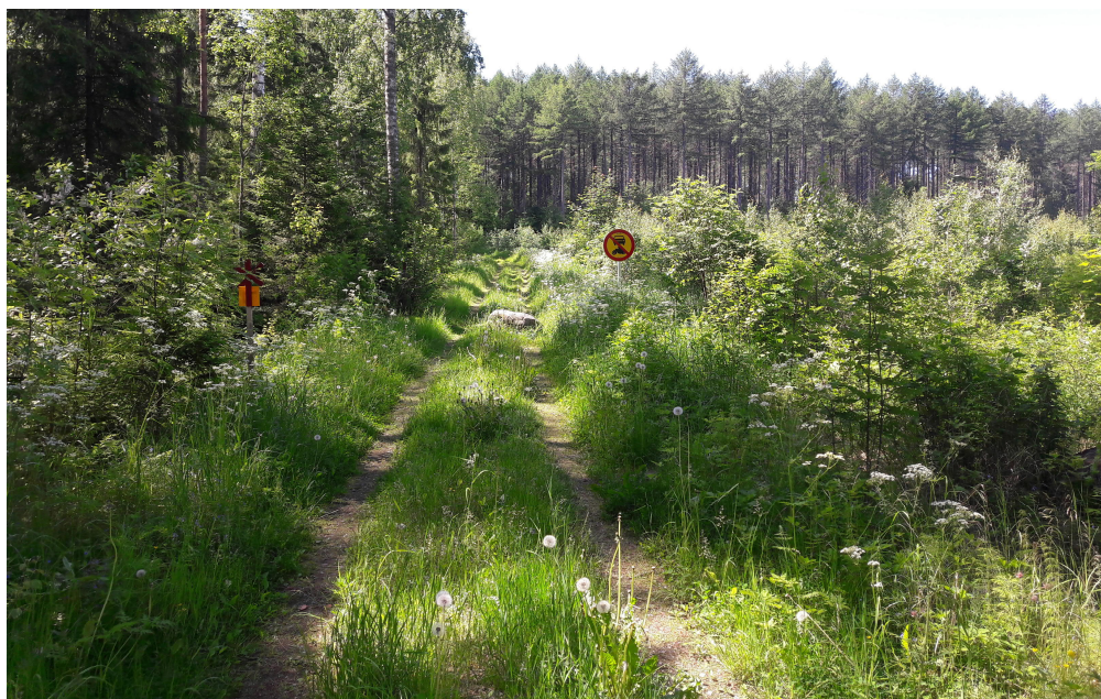
Vanhan Viipurintien pohjoispää kuvattuna pohjoisesta.
