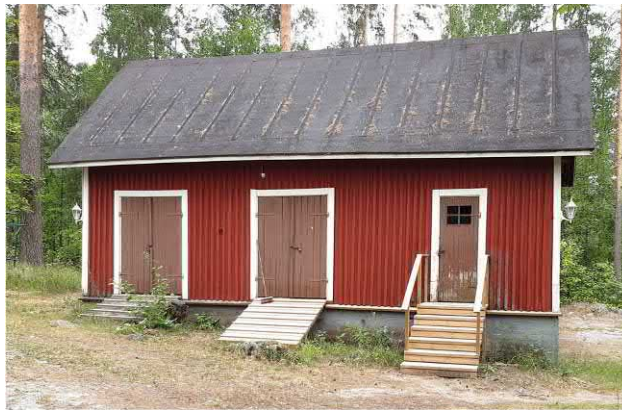
Metsäkonttorinkuja 6, talousrakennus etelästä.
