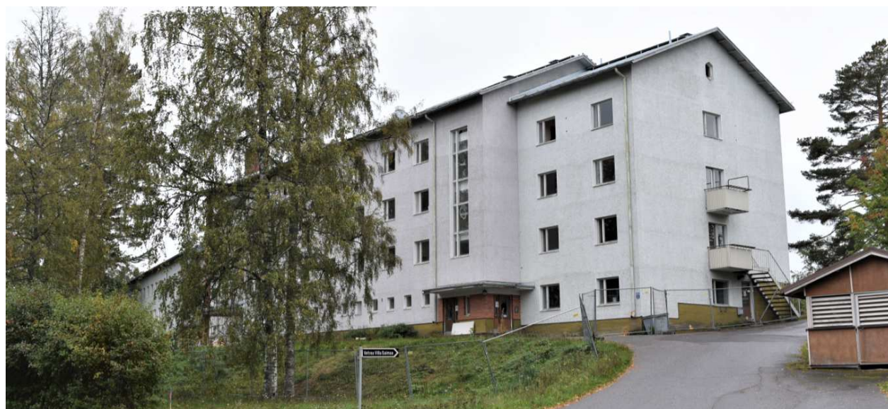
Kuva: Savonlinnan Pihlajakoti eli entinen vanhainkoti jäi tyhjilleen 2010-luvun alussa. Rakennukselle on myönnetty purkamislupa ja sen tilalle on suunniteltu vanhusten palvelutaloa.
