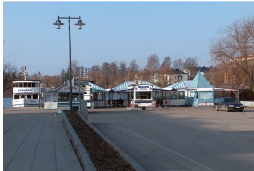
Torin järven päädyn kiinteät kioskirakennelmat kannattaisi mahdollisen kunnostuksen yhteydessä avata osin järvelle ja näköalojen suuntaan.
